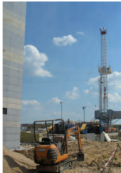
Wiertnia w pobliżu SOLPARKU. Z pracami prowadzonymi w roku 2009 wiązano nadzieje na powstanie geotermalnych basenów.
