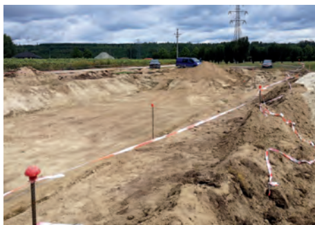
Początek sierpnia - rozpoczęta budowa zbiornika
