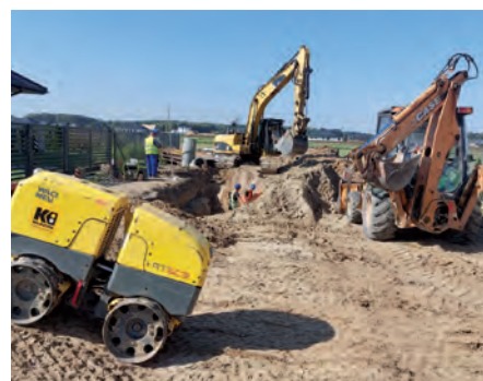
Sterowany zdalnie walec pomaga w zagęszczaniu gruntu
