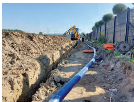
Wraz z układaniem wodociągu...
