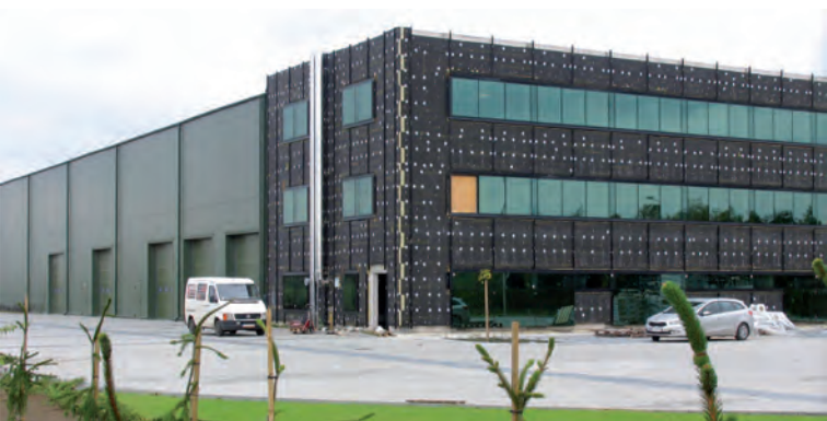
Wielka hala firmy Goodrill, zbudowana została na przełomie 2016/17
