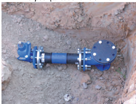
... montowane są zasuwy i indywidualne przyłącza do posesji
