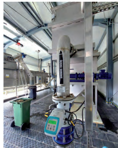
W tej hali ze ścieków surowych są oddzielane tzw. skratki i piasek
