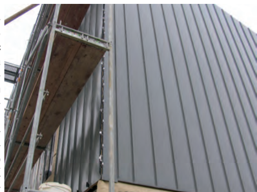
Panele z blachy układanej „w rąbek” na elewacji budynku archiwum w Kleszczowie
