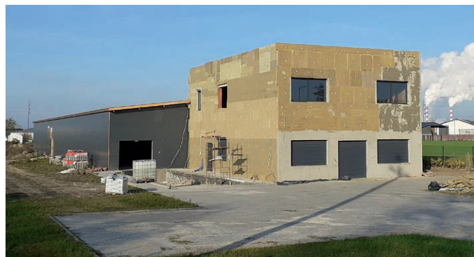
W trakcie realizacji jest zakład spółki INSPIRE
