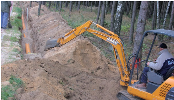
Przy obwodnicy przebiega gazociąg średniego ciśnienia, zasilający firmy ze strefy „Bogumiłów”
