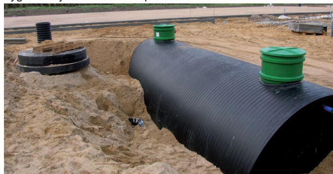
Ten zbiornik zbierze wody opadowe, będą wykorzystane do podlewania murawy
