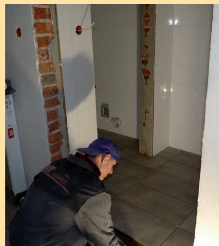
Końcowe prace przy układaniu ceramiki
