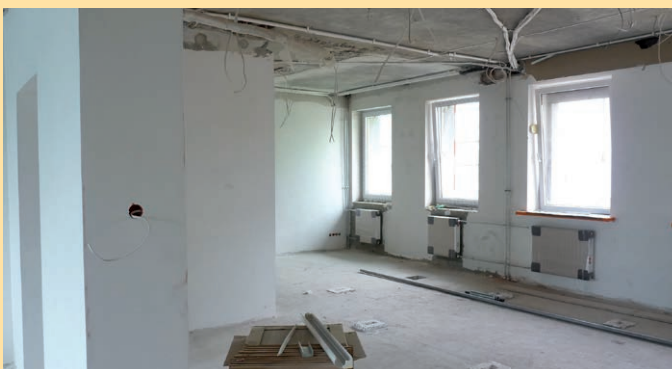
Powiększona sala na parterze przeznaczona na cele szkoleniowe
