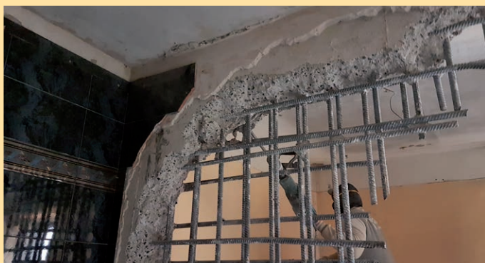
Wyburzanie ścian bankowego skarbcza
