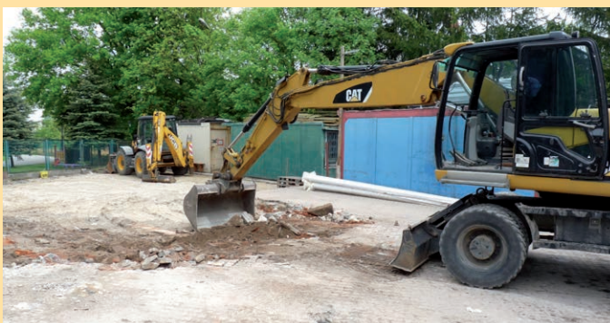
Usuwanie starej nawierzchni z dziedzińca
