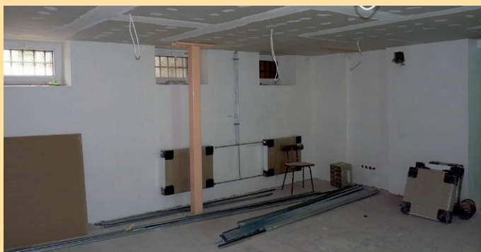
Duża klimatyzowana sala na najniższej kondygnacji
