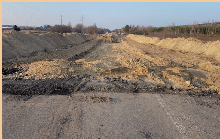
Stan prac przy nowym nasypie na dzień 30 marca
