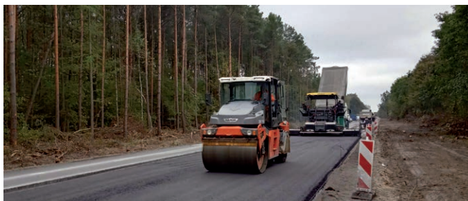
Rozbudowa drogi Czyżów - Kalisko to jedno z najważniejszych zadań
