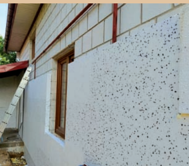
Prace dociepleniowe - zdjęcie udostępnione przez jednego z beneficjentów
