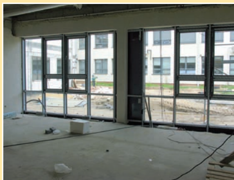
Szkolna świetlica wyróżnia się wielką, przeszkloną ścianą
