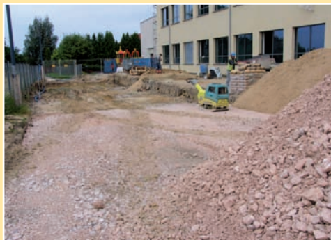
Tędy prowadzić będzie droga otaczająca szkolne budynki
