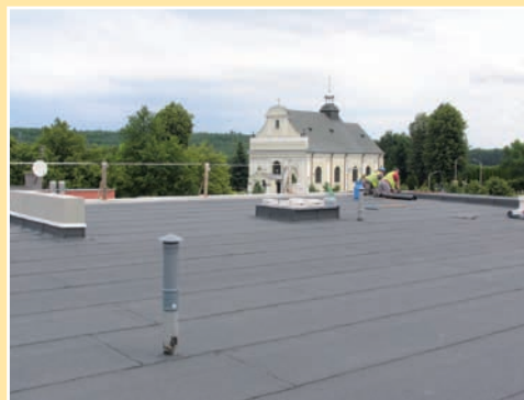
Tak wygląda ostateczne pokrycie dachu nowej części szkoły
