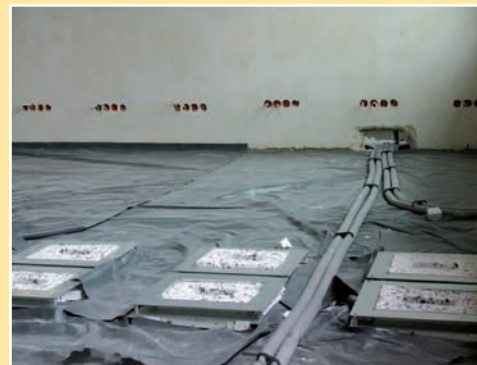
Posadzka w sali informatycznej przygotowana do wykonania wylewki
