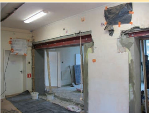
Dla powiększenia szkolnej stołówki konieczne było wyburzenie części ściany
