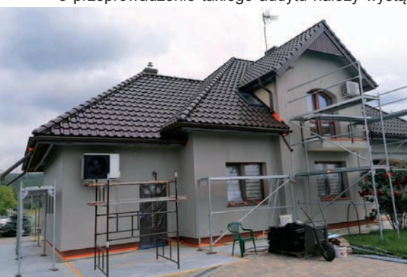
W tym roku na prace termomodernizacyjne zdecydował się m.in. właściciel tego domu w Czyżowie
