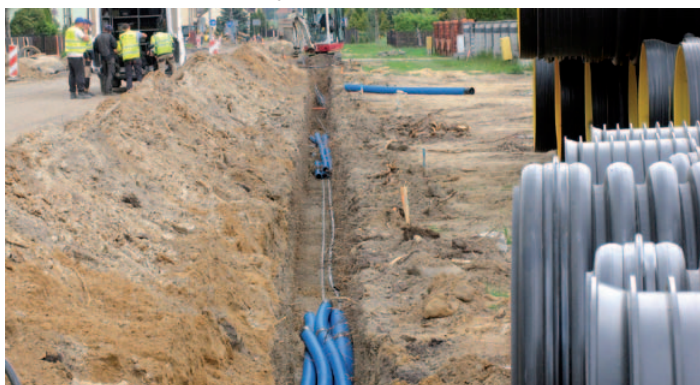
Układanie podziemnych kabli elektrycznych niskiego napięcia
