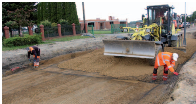
Układanie siatki wzmacniającej na piaszczystym podłożu
