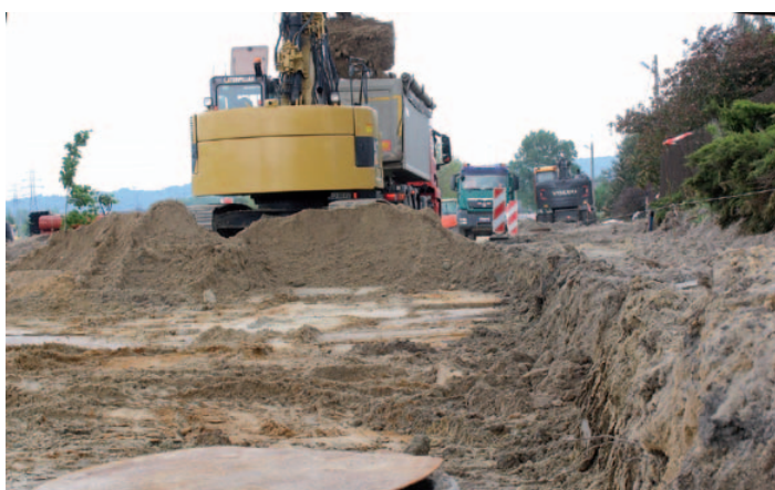
Z miejsca, gdzie ma przebiegać nowa jezdnia, zdejmowana jest solidna warstwa gruntu
