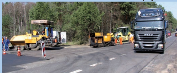
Naprawa fragmentu jezdni na drodze Piaski-Rogowiec
