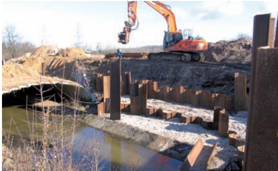
Budowa tymczasowego koryta dla systemu odwodnienia
