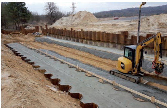
Podbudowa pod konstrukcję docelowego kanału
