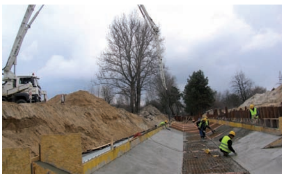
Betonowanie właściwej konstrukcji kanału odwadniającego
