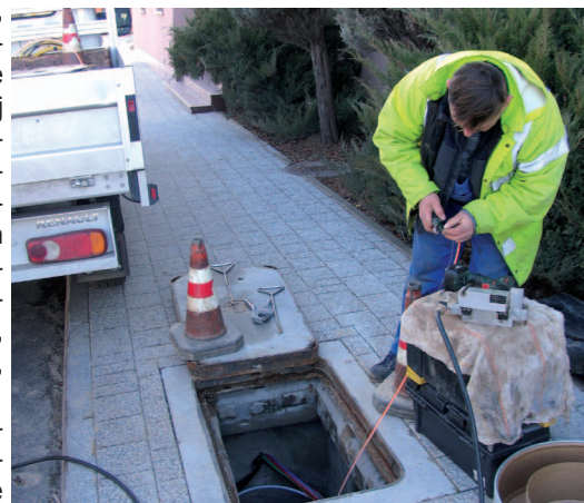
Prace przy sieci światłowodowej na ul. Urzędowej w Kleszczowie
