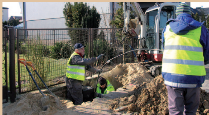
Na ulicy Cichej elektrycy układają kabel do zasilania latarni
