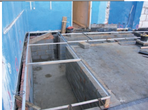
Kanały technologiczne w głównym budynku
