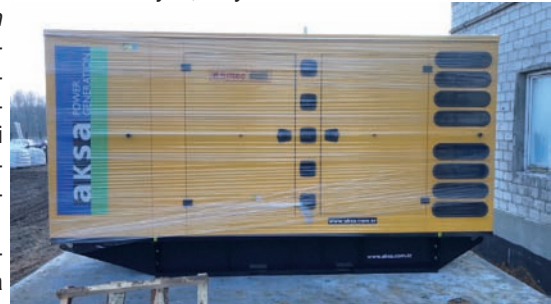
Agregat prądowładczy przeznaczony dla SUW w Łękińsku
