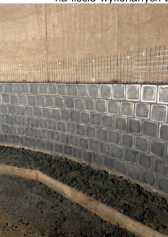
Ściany zbiornika wykładane płytkami bazaltowymi
