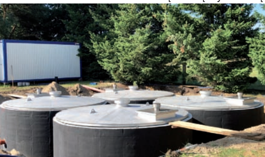
Nowe komory odstojnika popłuczyn (stan prac z września)
