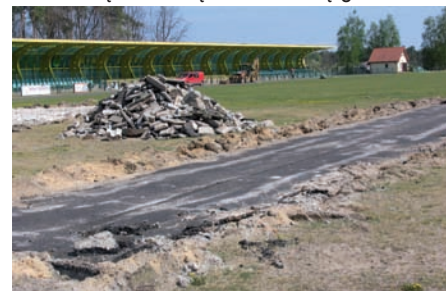
Pod koniec kwietnia ruszyły prace przy zdejmowaniu starej nawierzchni
