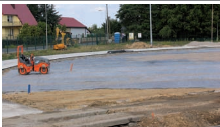
W sierpniu trwały prace przy układaniu kolejnych warstw drenażu
