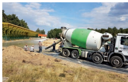
Układanie betonowej konstrukcji bieżni zakończyło się w lipcu
