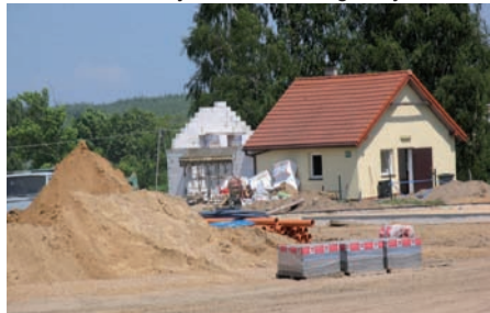
Upalny czerwiec sprzyjał ekipie, zajmującej się rozbudową pomieszczeń gospodarczych
