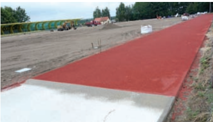
Początek września to prace nad układaniem wierzchniej, poliuretanowej warstwy na bieżni
