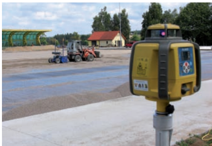
Specjalna aparatura sprawdzała właściwe wypoziomowanie warstwy żwiru
