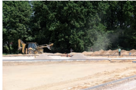
Po precyzyjnym wytyczeniu lekkoatletycznej bieżni zaczęto przygotowywać jej podbudowę
