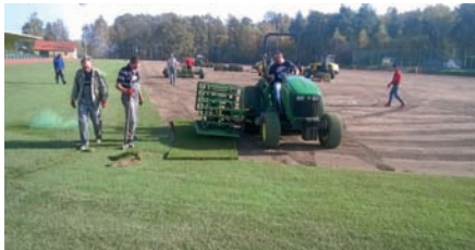
Do układania płyt murawy na boisku piłkarskim „zatrudniono” specjalną maszynę
