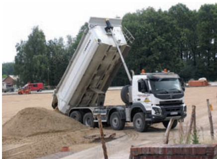
Kolejna warstwa drenażu boiska piłkarskiego wykonana została z piasku
