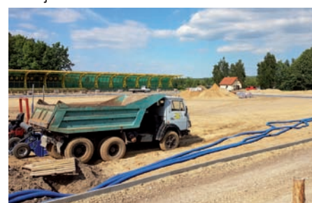
Dla uzyskania dobrego drenażu zastosowano grubą warstwę piasku oraz opaskę z rur
