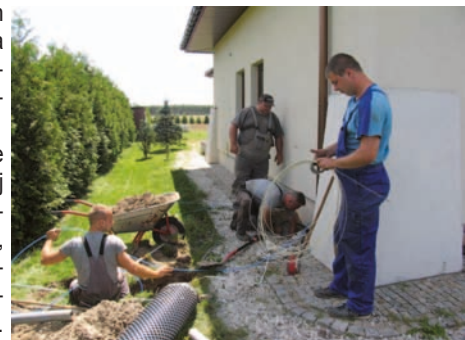
Ekipa instalatorów w trakcie prac przy podłączaniu linii światłowodowej
