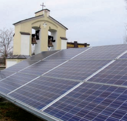
Wśród montowanych urządzeń nadal dominują panele fotowoltaiczne
