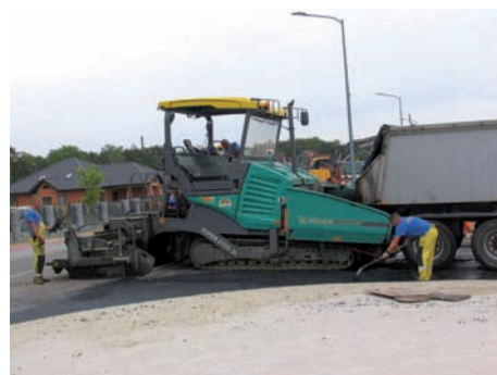
W tym miejscu drogowcy rozpoczęli ostatni etap prac
