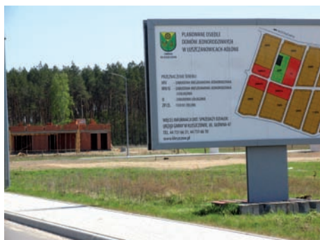
Na niektórych działkach trwa już budowa domów
