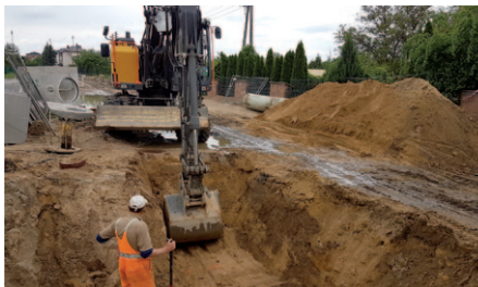
Miejsce, w którym konieczna była przebudowa magistrali gazowej
