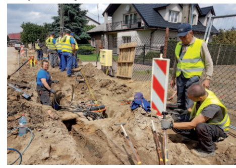
Instalatorzy przy sieciach energetycznych i światłowodowych
