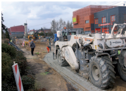
Specjalna maszyna do rozkładania mieszanki piasku i cementu
