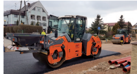
Prace bitumiczne w sąsiedztwie Urzędu Gminy
