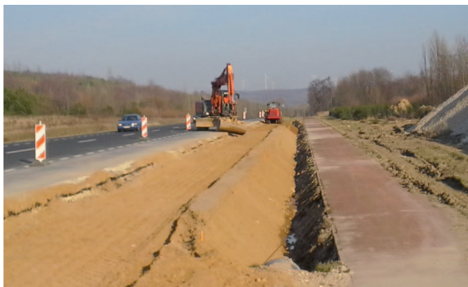
Prace przy dodatkowym tzw. pasie włączającym
