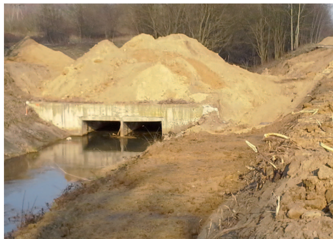
Przebudowa przepustu oznacza przemieszczenie dużych mas ziemi
