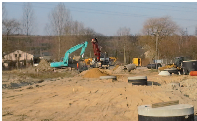
Przy ul. Topolowej ułożono nowe fragmenty kanalizacji
