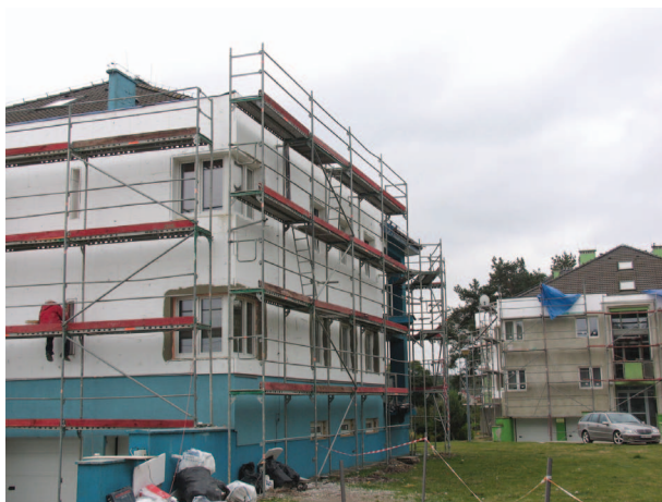
Październik 2016 – prace termomodernizacyjne
