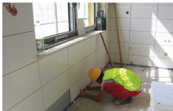
Sierpień 2017 - prace na zapleczu kuchennym przedszkola
