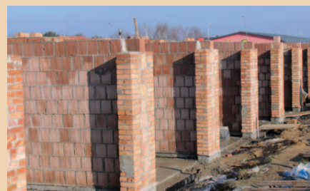
Garaże czekają na przykrycie stropodachem
