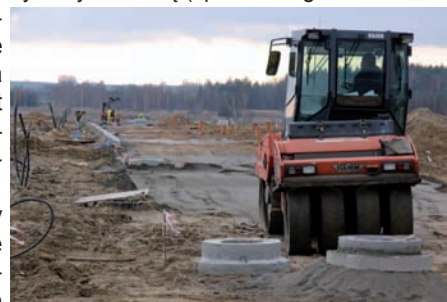
Widać już wyraźnie przebieg kolejnej, osiedlowej ulicy
