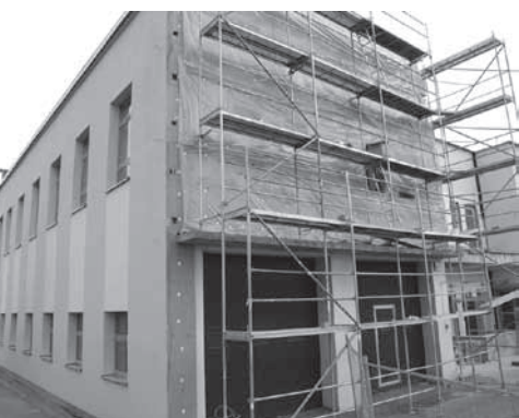
Jedną z inwestycji, które prowadziła firma Budmont była modernizacja domu kultury w Antoniówce
