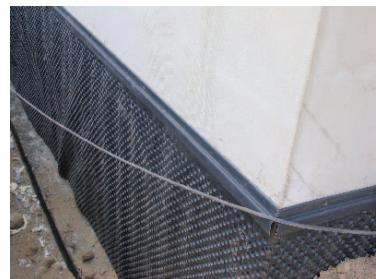
Nowe izolacje ścian fundamentowych
