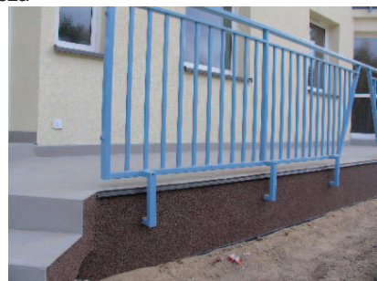
Odnowiony taras w jednym z budynków
