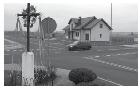
W miejscu obecnego skrzyżowania ulic Słonecznej i Milej powstanie kolejne w naszej gminie rondo.
