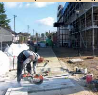
Układanie chodnika z granitowych płyt
