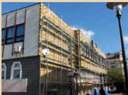
Budynek otoczony rusztowaniami
