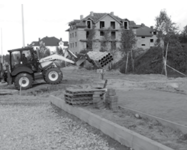
Już widać fragment ciągu pieszo-jezdnego. W tle – spółdzielcze budynki.
