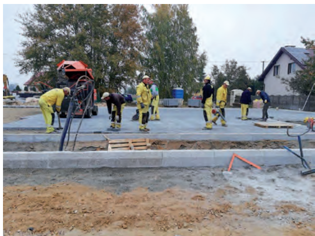
JS Prace przy układaniu nawierzchni nowego parkingu
