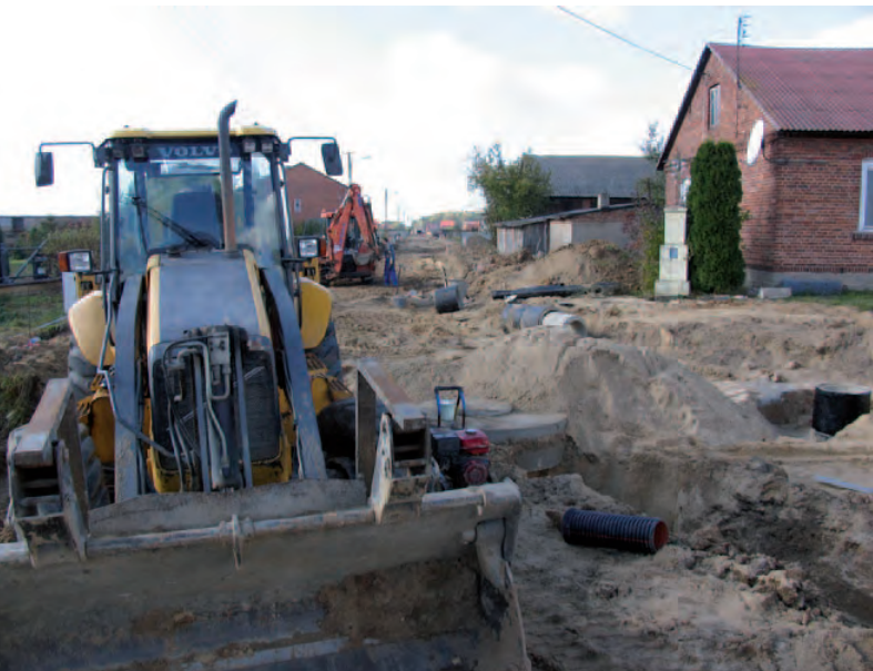
Jesień 2011 roku – początek robót przy ul. Ustronnej w Łękińsku
