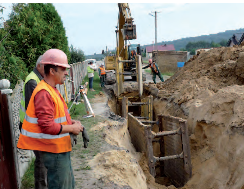
Pierwsze odcinki kanalizacji sanitarnej w Czyżowie
