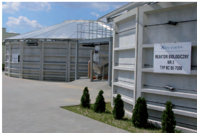
Nowa oczyszczalnia w Żłobnicy składa się z dwóch reaktorów biologicznych
