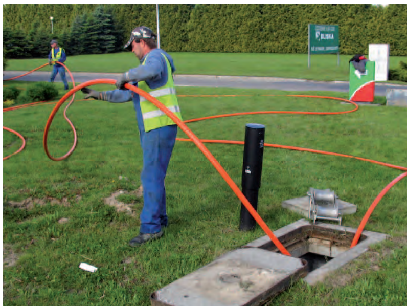
Światłowody są umieszczane w specjalnej osłonie
