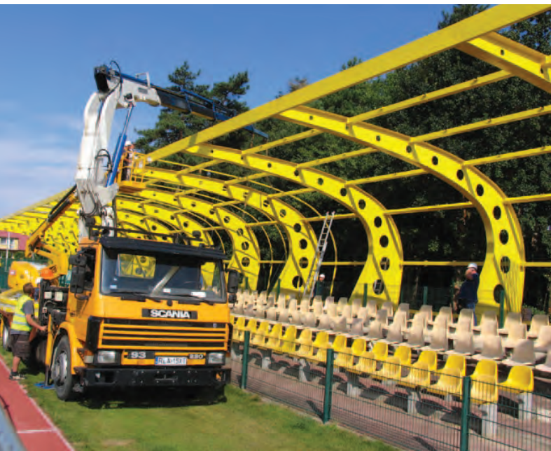
Montaż konstrukcji zadaszenia trybun na stadionie gminnym w Kleszczowie
