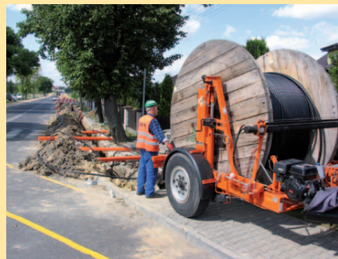
Układanie kabla przy ul. Słonecznej
