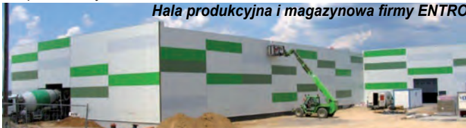
Hala produkcyjna i magazynowa firmy ENTRO
