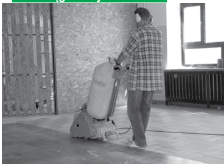
Cyklinowanie parkietów holu na I piętrze
