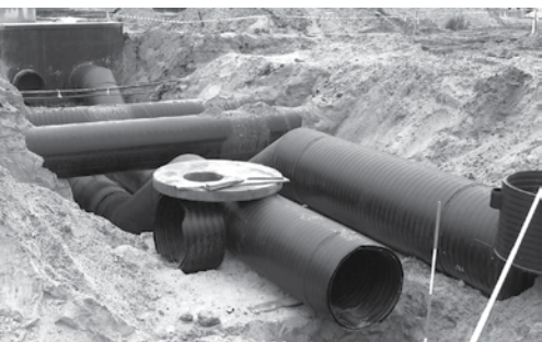
Rury z KWH Pipe wykorzystywane były m.in. do odwodnienia terenów strefy przemysłowej w Bogumiłowie
