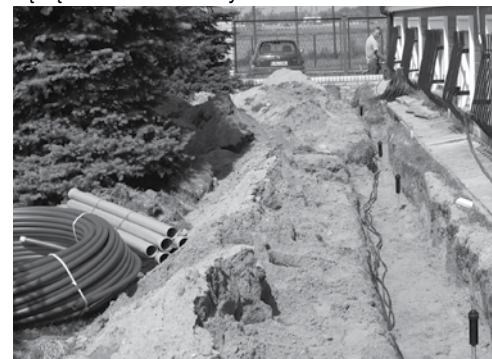
Budowa instalacji zraszania
