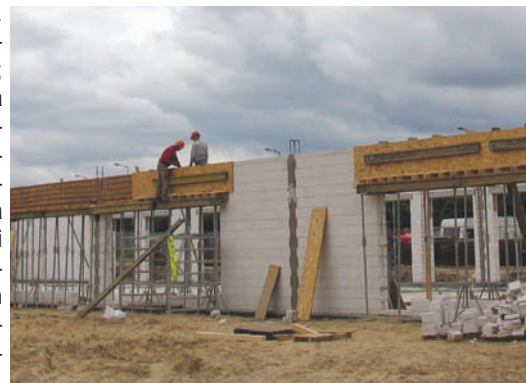
Lipiec - montaż szalunków przy podciągach
