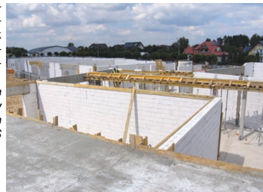
Połowa sierpnia - widok budowy z poziomu I piętra
