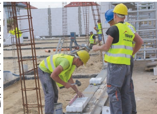
Czerwiec - murarze przy pracy
