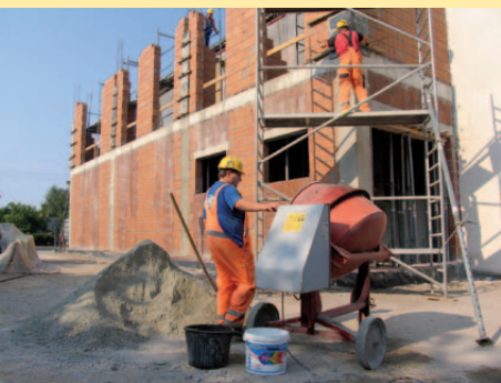
Murarze kończą prace przy nowej zewnętrznej ścianie
