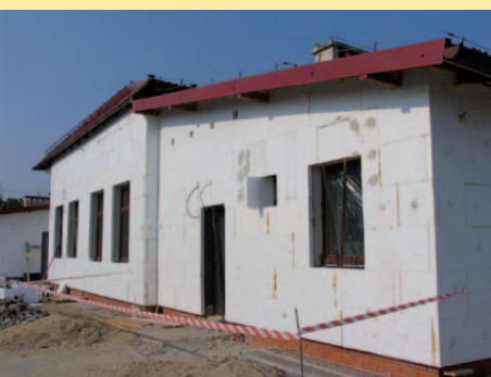
W połowie sierpnia kończono docieplanie ścian zewnętrznych
