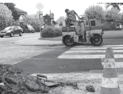
Naprawa nawierzchni ul. Osiedlowej w Kleszczowie
