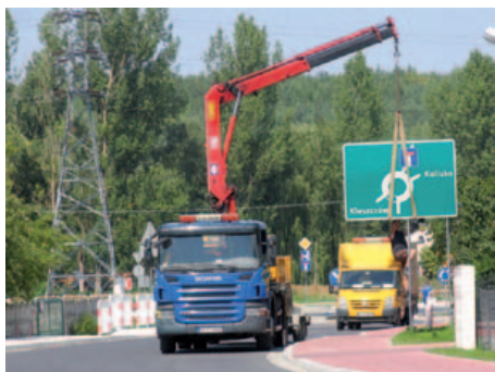
Montaż tablic informacyjnych
