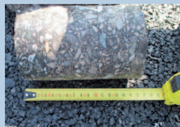
28 lipca badana była jakość wykonania przebudowywanej od kilkunastu miesięcy drogi „przy starej szkole” w Wolicy
