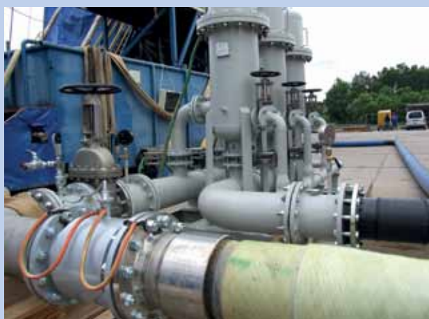
Ta skomplikowana instalacja została przygotowana do wykonania pompowania próbnego
