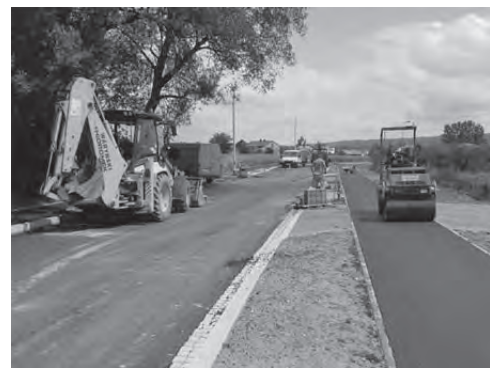
Przebudowa drogi „przy starej szkole” - stan prac z 11 lipca
