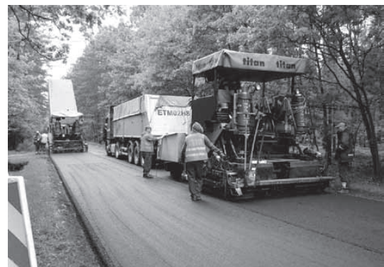
Nową warstwę ścierną układano jednocześnie na całej szerokości jezdni
