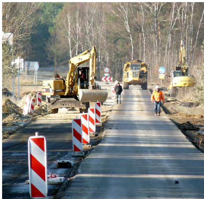
Listopad 2015 – przebudowa pierwszego odcinka drogi Kamień - Chabielice
