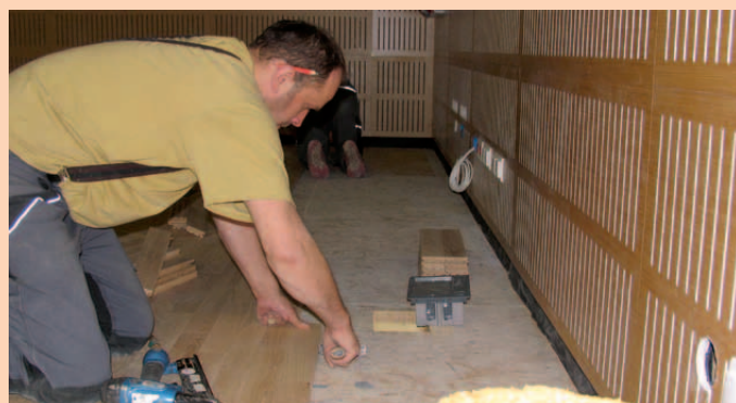
Końcowe prace przy układaniu dębowego parkietu na scenie
