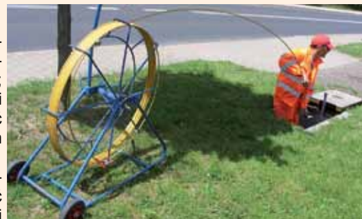
Przygotowania do rozprowadzenia sieci światłowodowych
