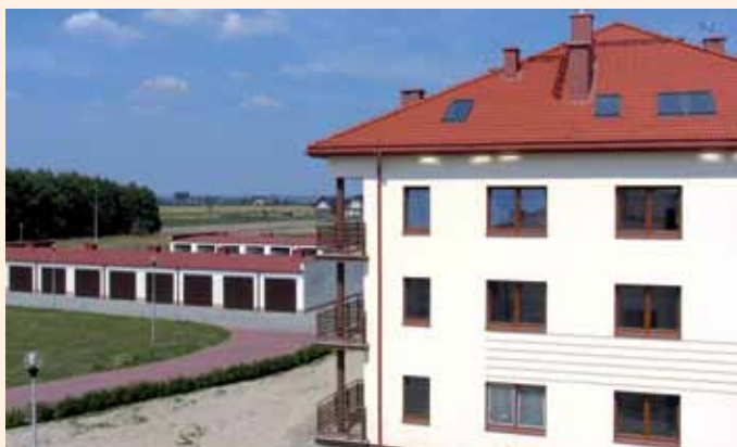
Na osiedlu „Łuszczanowice” zbudowane zostały 4 takie budynki
