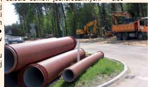
Podziemne sieci powstają z rur o różnym przekroju
