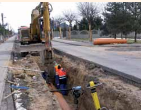
Przebudowa każdej z dróg rozpoczyna się od takich robót
