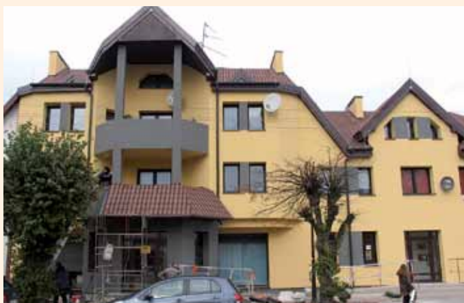
Docieplony budynek przy ul. Głównej 112 w Kleszczowie z nową elewacją
