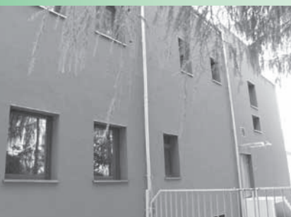
Elewacja po północnej stronie budynku została już wykonana
