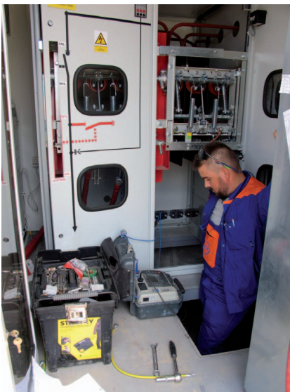
Prace instalacyjne we wnętrzu stacji STKL-5
