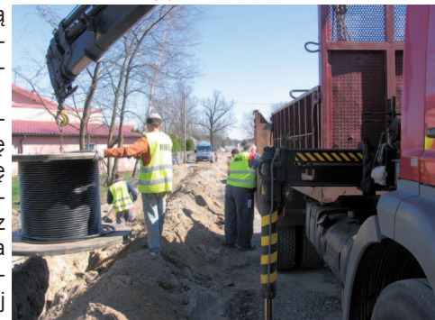
Układanie kabla zasilającego lampy uliczne w Łuszczanowicach Kolonii
