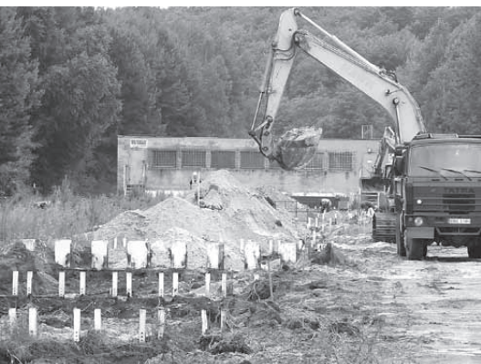
Część rurociągów, które od 1981 roku obsługiwały system odpowielania Elektrowni Bełchatów, została już zdemontowana
